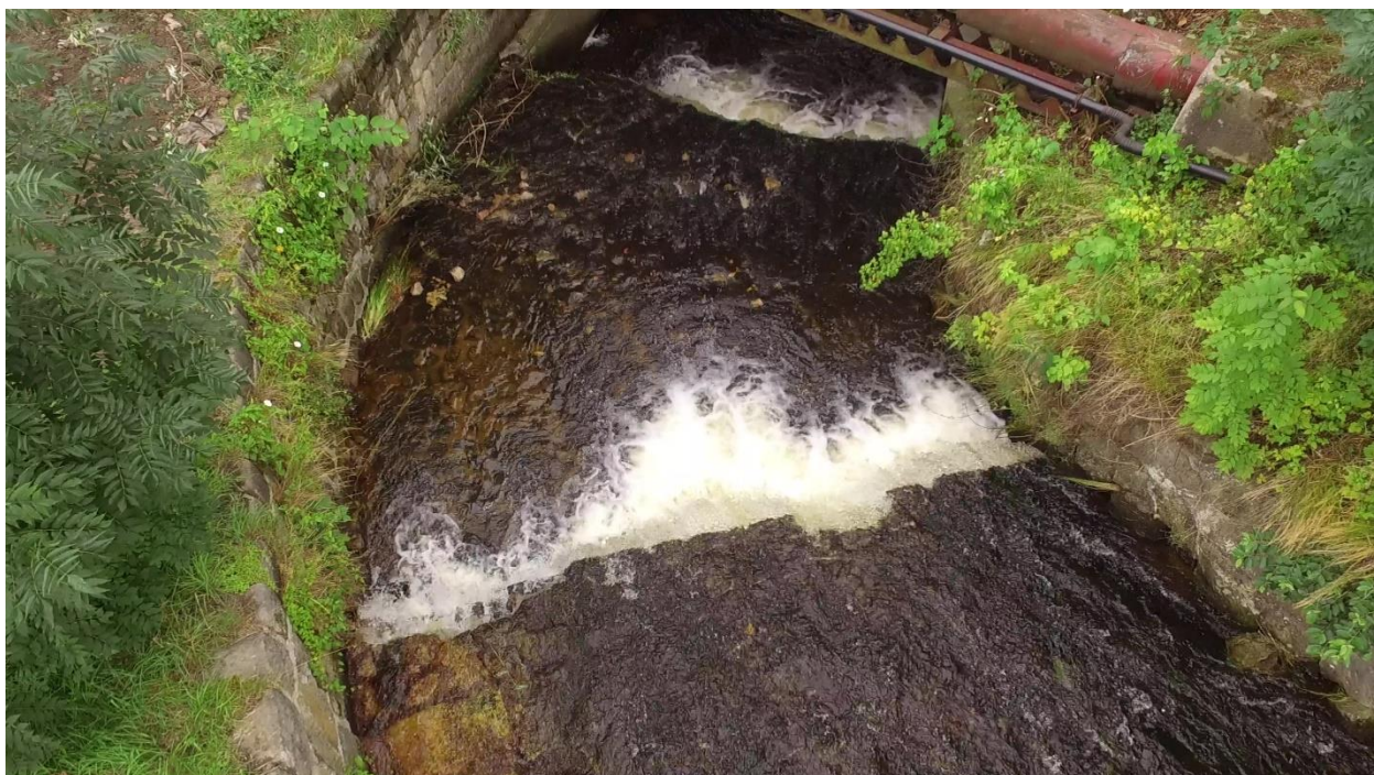
Obrázek 11 Celkový pohled na oba stupně. Na horním stupni je viditelné poškození přelivné hrany.
