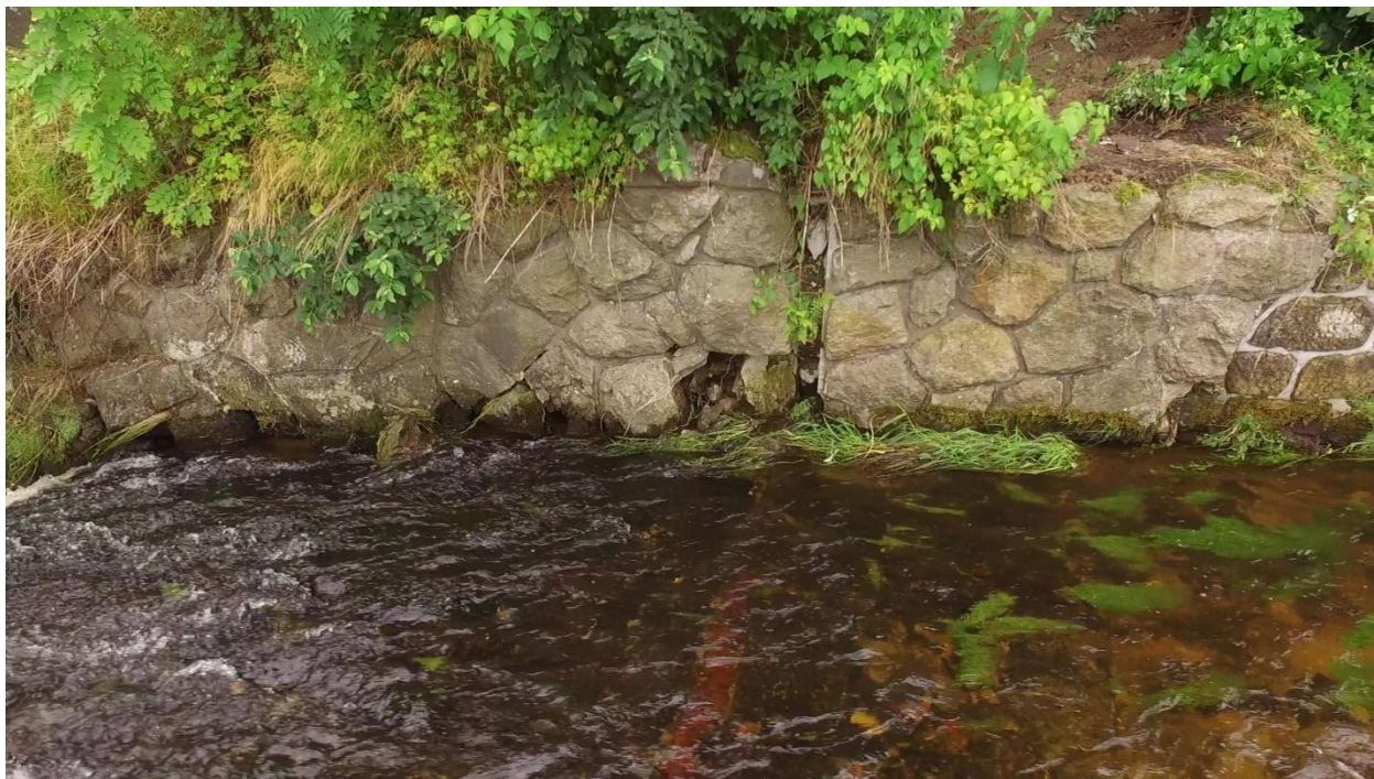
Obrázek 10 Pravobřežní zeď, na pravém okraji viditelné napojení na již opravenou zeď z pískovcového řádkového zdiva. Uprostřed fotky hradící profil.
