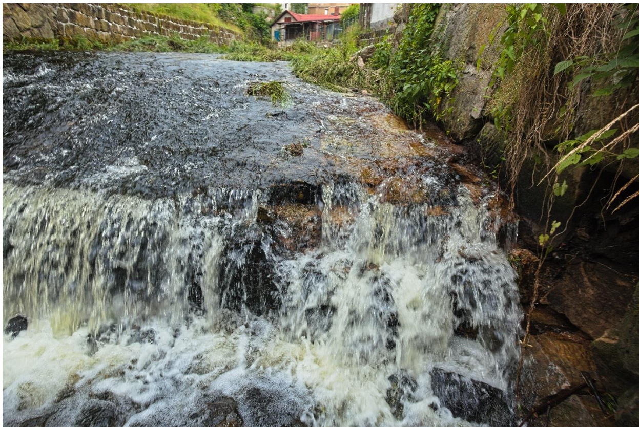
Obrázek 12 Poškození horního stupně v levobřežní části a poškození přilehlé zdi
