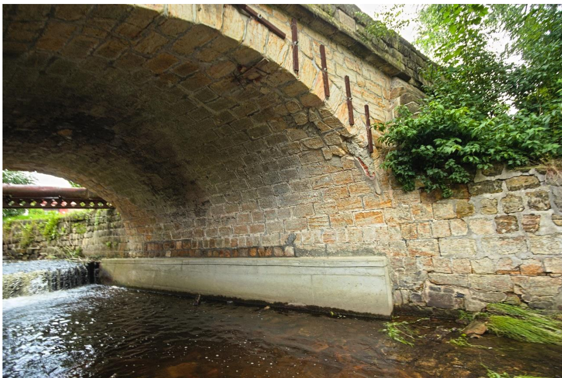
Obrázek 16 Pohled na levobřežní opěru mostu s betonovou předpatkou
